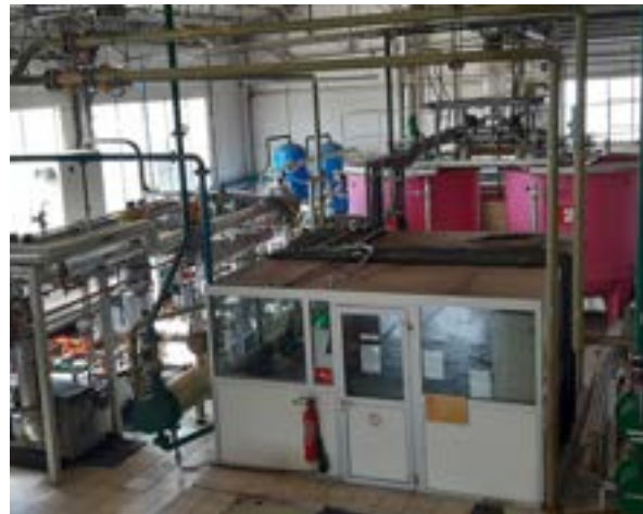
Salle de fabrication
